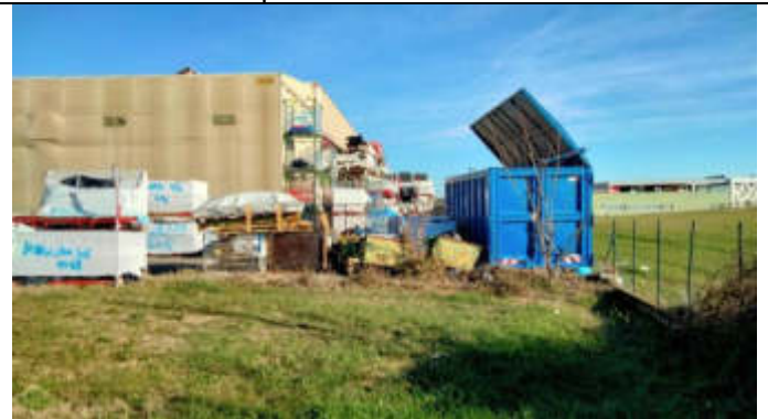
Lapi Plast – lato sud-est
