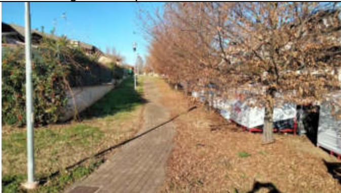
Viale di accesso al parco pubblico – lato sud est
